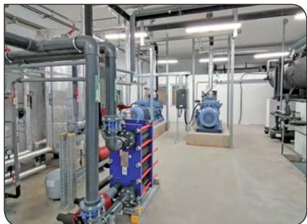
4 | Rekonštrukcia „zimáku“ Zimný štadión má nové chladenie a betónovú plochu
